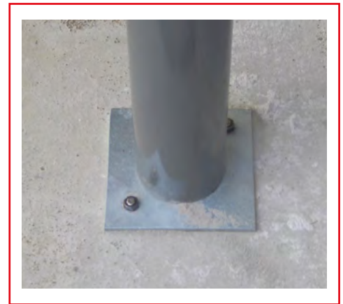
Ter plaats gemaakte fundering
