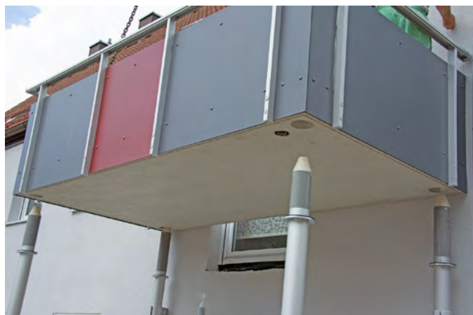
4. Balkon voor de bovenverdieping wordt op de steunen geschroefd.
