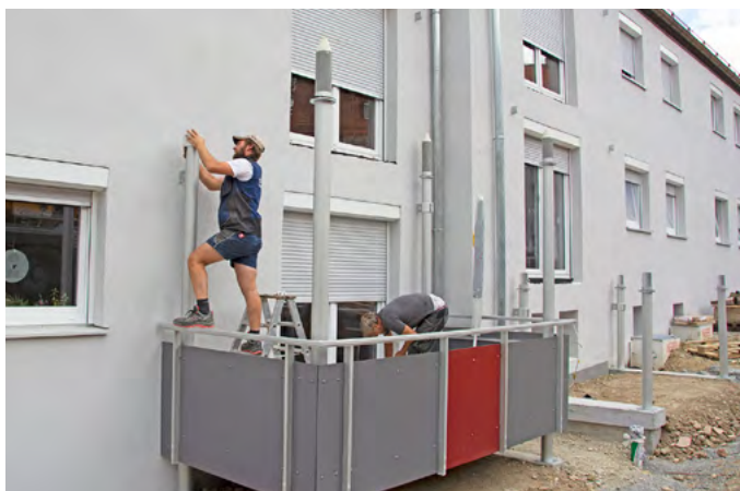
3. Bevestigen van de steunen; vastschroeven aan de muur met muurbeugels
