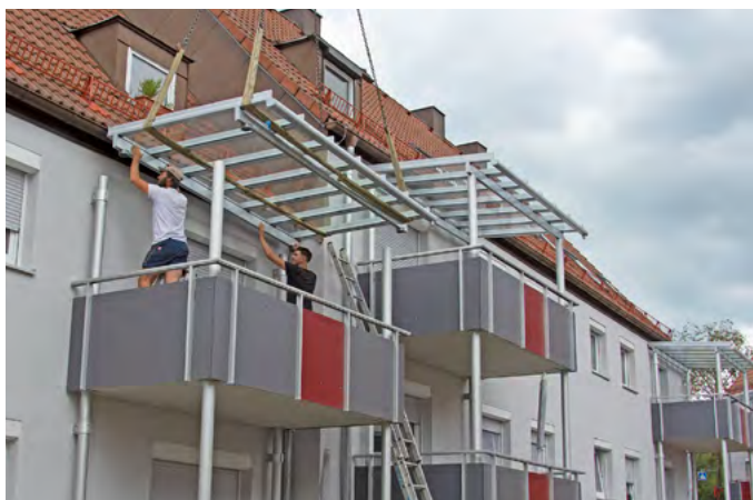
5. Installatie van het balkondak
