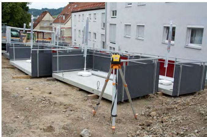
1. De balkons voorbereiden, de leuningen installeren
